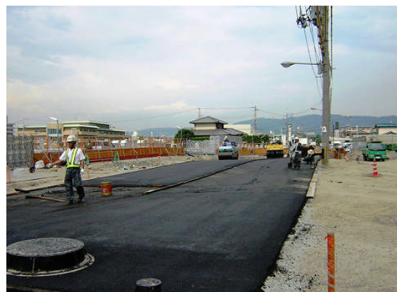
▲アスファルト敷設
