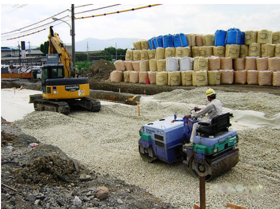
▲敷き均し・転圧
