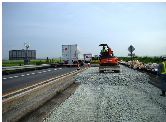
▲二層目敷き均し
