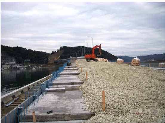
▲階段式段差部分
