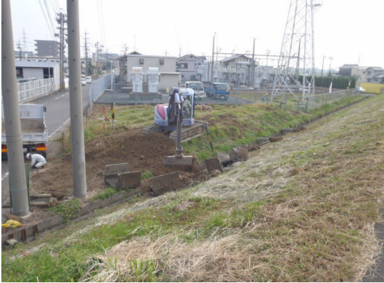
▲現場状況（施工前）
