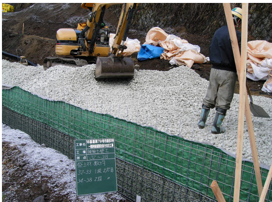
▲補強土壁工2段目2層目・敷均し
