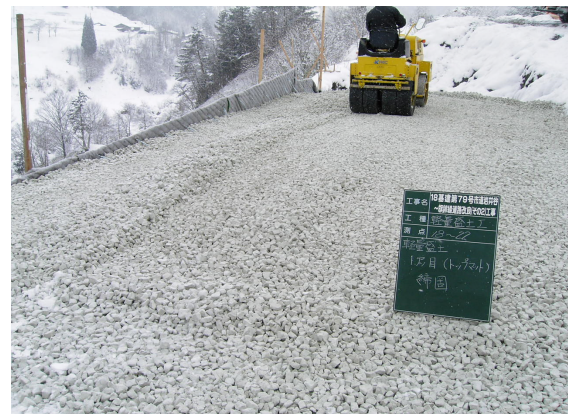
▲軽量盛土工 締固め
