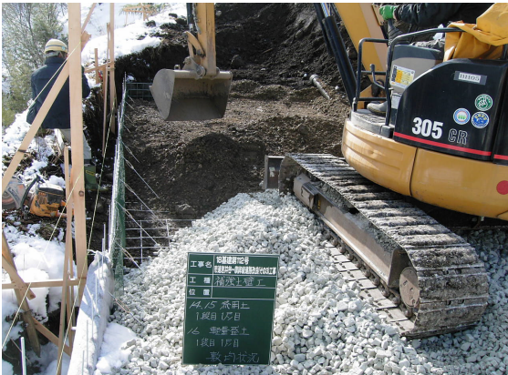
▲補強土壁工1段目1層目・敷均し
