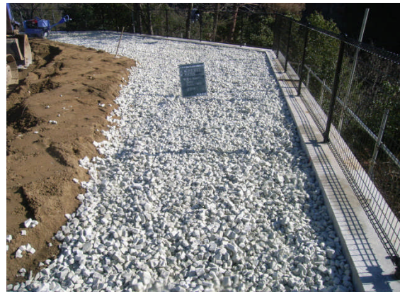
▲軽量盛土工完了
