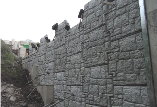
▲テールアルメ外観
