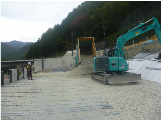
▲投入・敷均し
