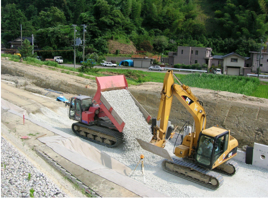
▲スーパーソイル投入
