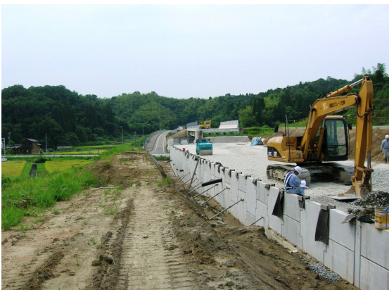
▲敷き均し・転圧
