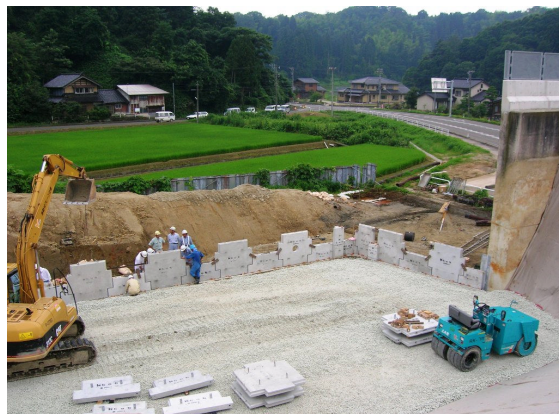
▲壁面材組み立て
