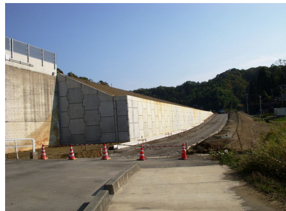
▲裏込め完了（舗装前）
