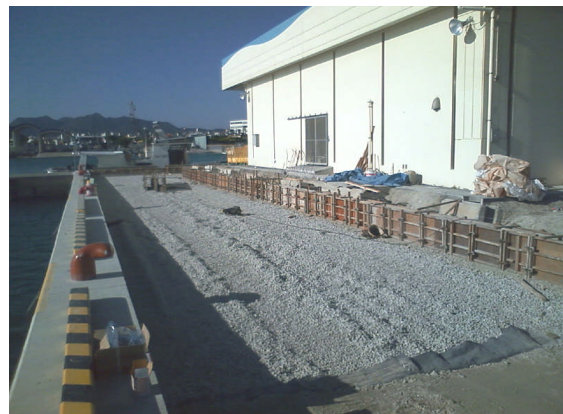
▲スーパーソル敷設完了
