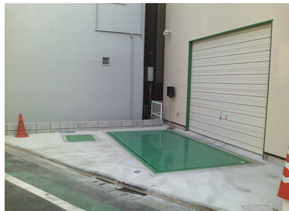
▲トラックスケール完成
