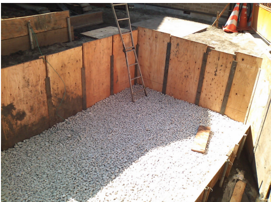
▲スーパーソル施工完了
