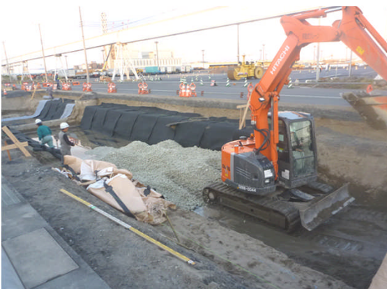
▲投入・敷均し
