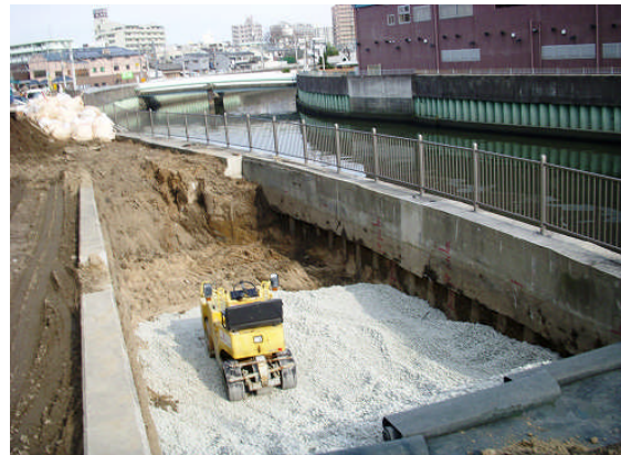
▲敷き均し、転圧
