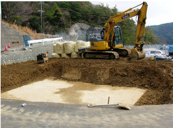
▲軽量盛土工現場
