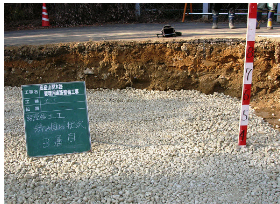
▲締固め状況 (3層目)
