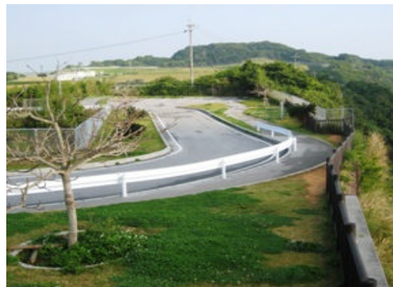
▲トンネル上部
