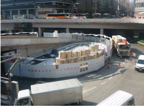
▲施工場所および搬入
