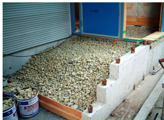
▲床下の投入状況
