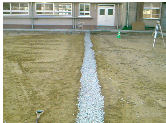
▲スーパーソル敷設
