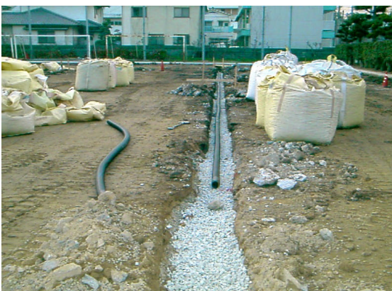
▲暗渠排水管埋設
