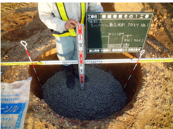
▲根底の排水基盤材にスーパーソル
