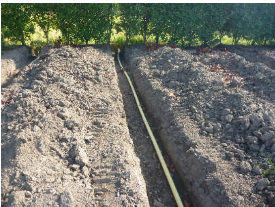
▲新暗渠管敷設
