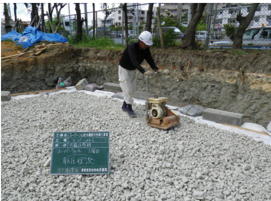
▲転圧状況（3層目）
