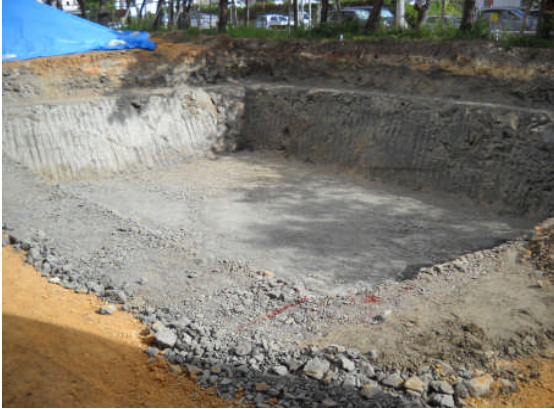
▲貯水槽部の掘削
