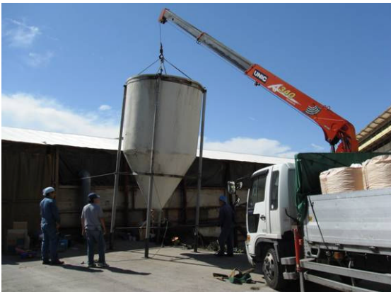
▲脱臭槽の設置
