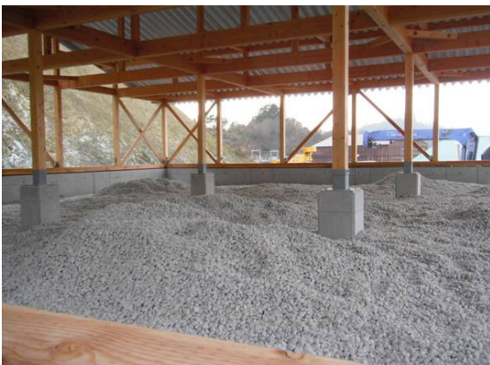
▲脱臭槽内の様子
